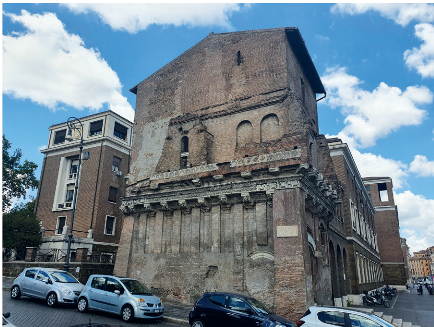
3) Casa dei Crescenzi – boczna fasada od Via di Ponte Rotto – kopia
