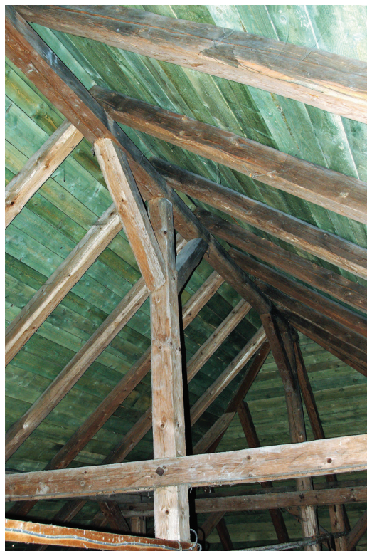
Ilustracja 62. Więżba dachowa nawy
