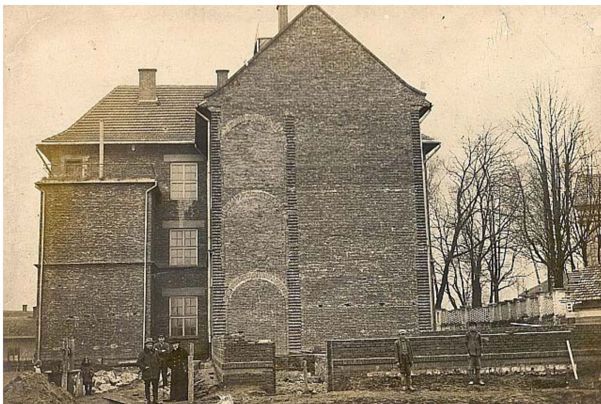
12. Budowa Szkoły Podstawowej Nr 1 w Kazimierzy Wielkiej, Archiwum SSP Nr 1 w Kazimierzy Wielkiej
