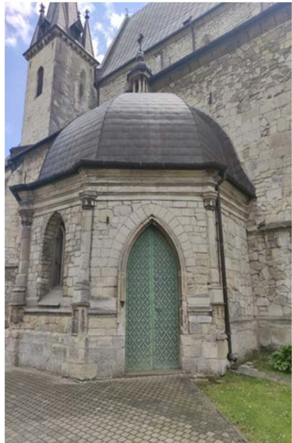
12. Skalmierz, kruchta północna, fot. autor
