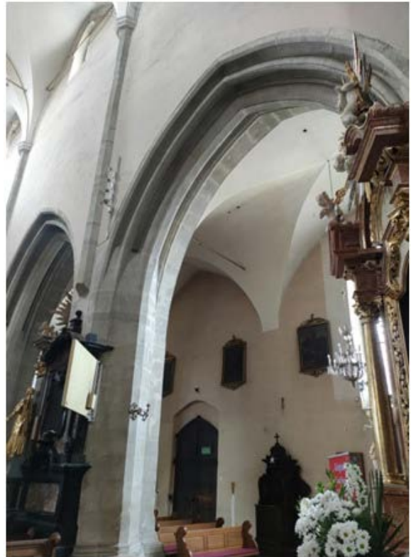
8. Skalmierz, widok na arkadę międzynawową, fot. autor
